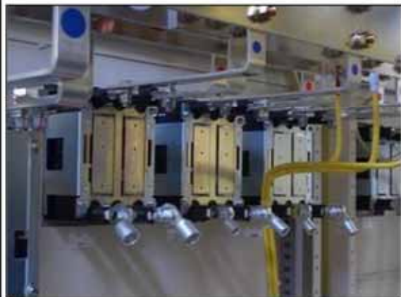
配線用遮断器(MCCB):埋め込み型 裏面
