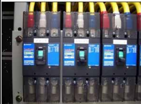
配線用遮断器(MCCB):裏面型 表面
