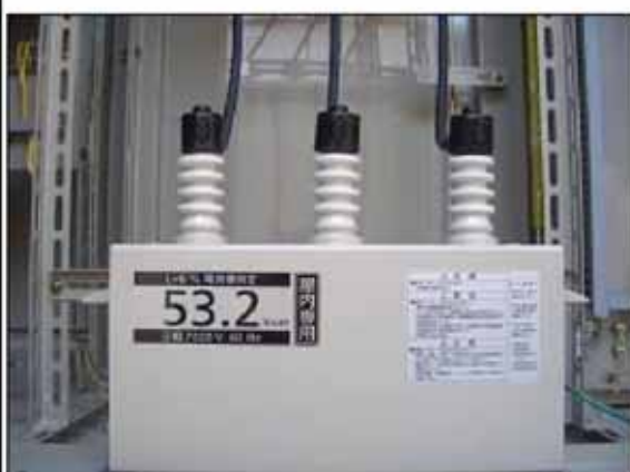
真空電磁接触器(VMC)
