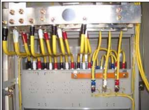
配線用遮断器(MCCB):裏面型 裏面
