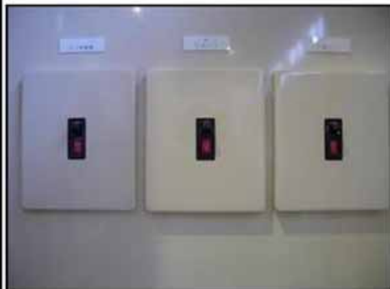
配線用遮断器(MCCB):埋め込み型 表面
