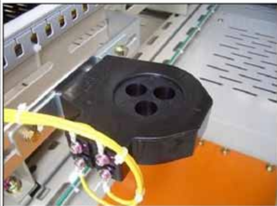
過電流継電器 (OCR)
