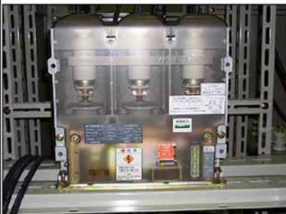
真空電磁接触器(VMC)
