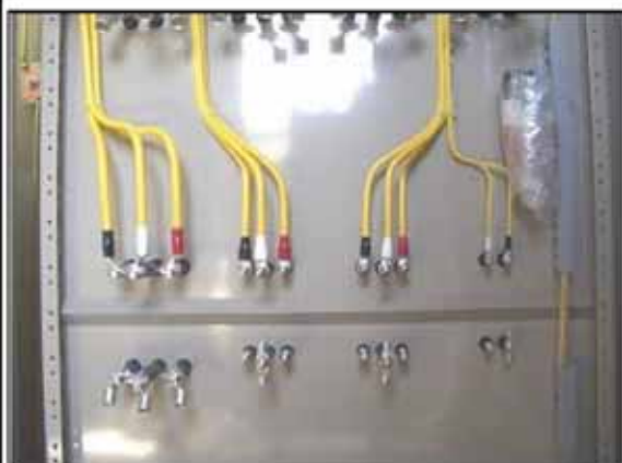
配線用遮断器(MCCB):埋め込み型 裏面
