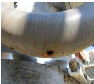
水抜き孔の加工
