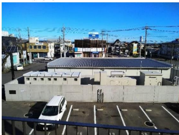
■ 塀の設置後の状況
